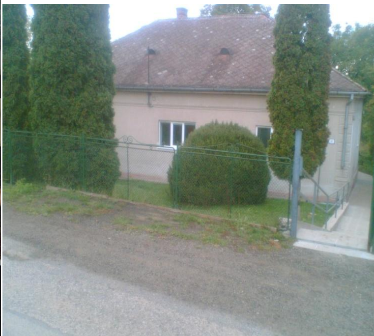
Rekonštrukcia chodníkov a interiéru budovy ZŠ
