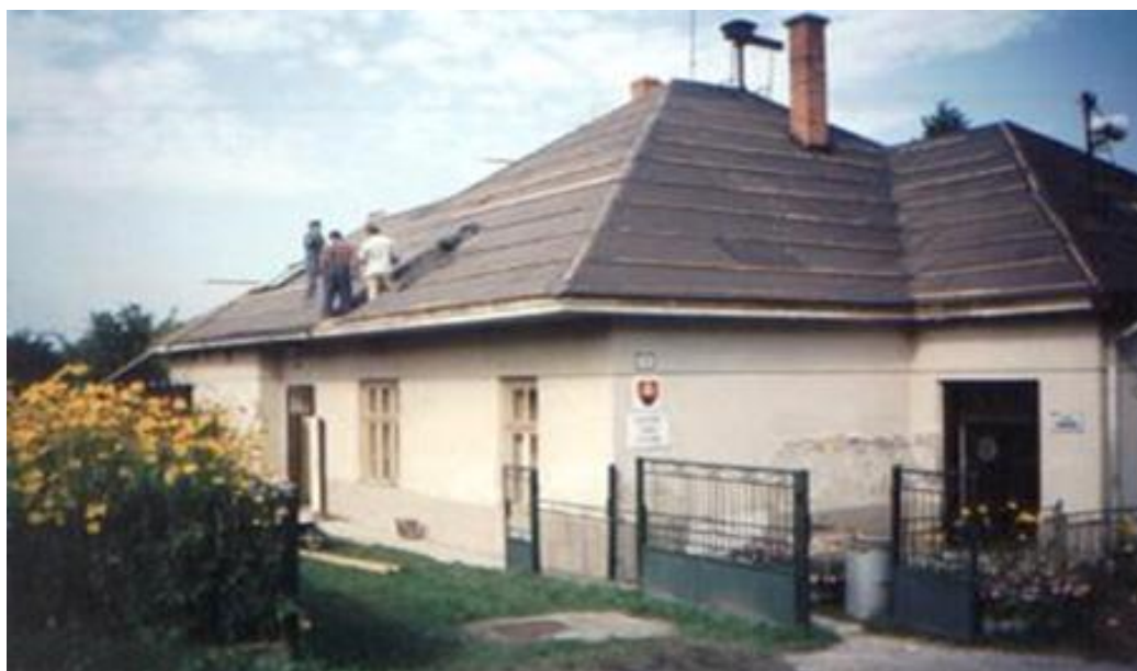
Celková rekonštrukcia budovy obecného úradu, prestavba interiéru, výstavba podkrovia
