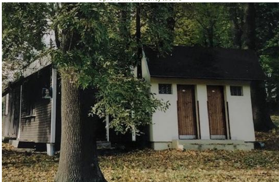
Výstavba verejných WC na parkovisku
