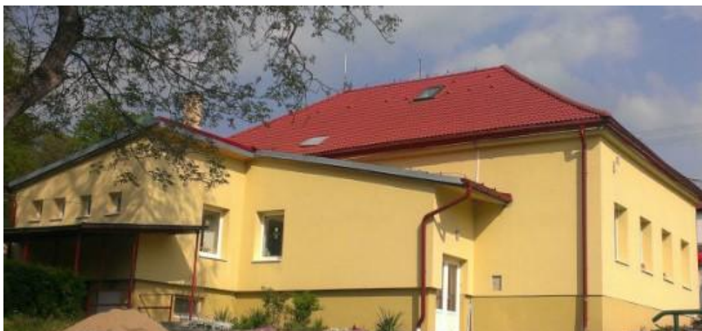
Zateplenie budovy ZŠ, nová strecha, zriadenie podkrovia a vonkajšie omietky
