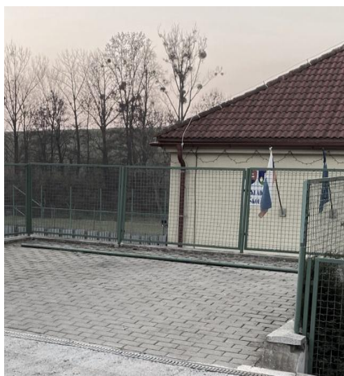
Výstavba parkoviska pre ZŠ
