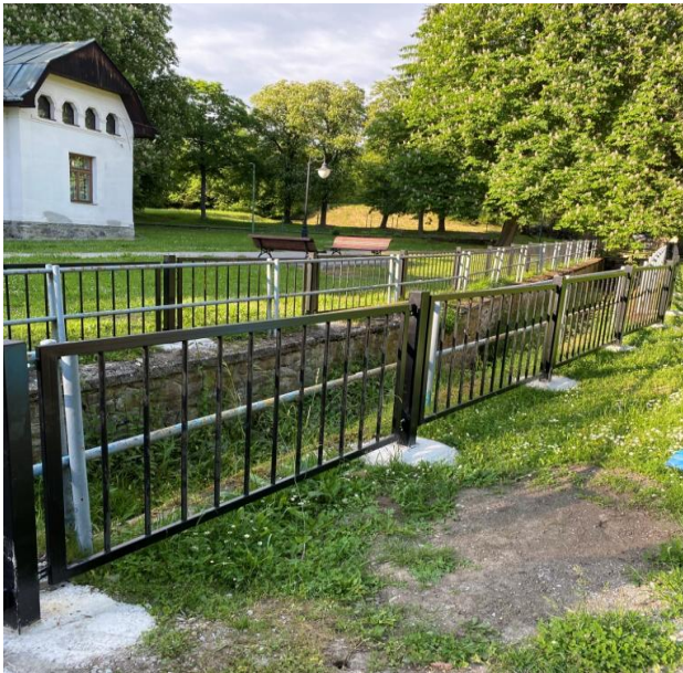
Nové zábradlia pri potoku
