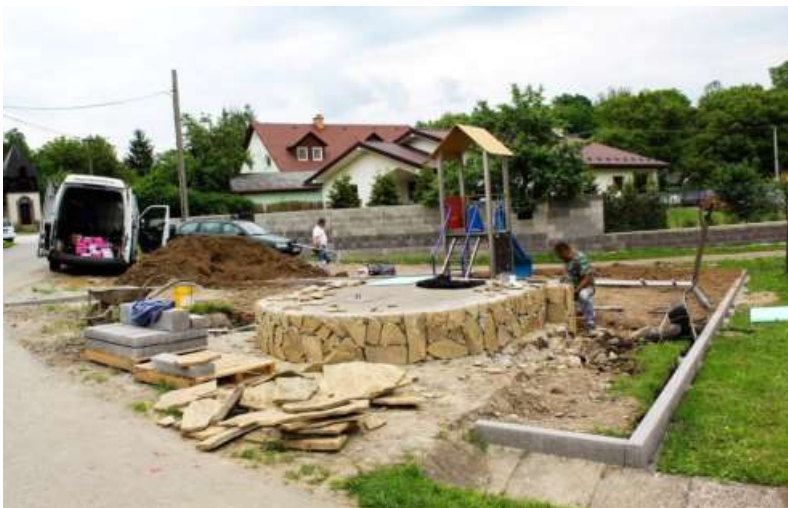
Výstavba detského ihriska v Žirovciach
