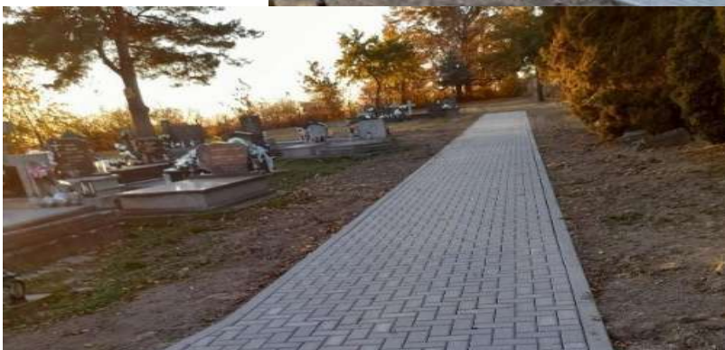
Výstavba chodníkov na žirovskom cintoríne
